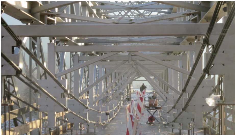
Slika 4 • Podporna konstrukcija v obstoječem mostu, kable za prednapenjanje in povezava med podporno konstrukcijo in konstrukcijo mostu.
