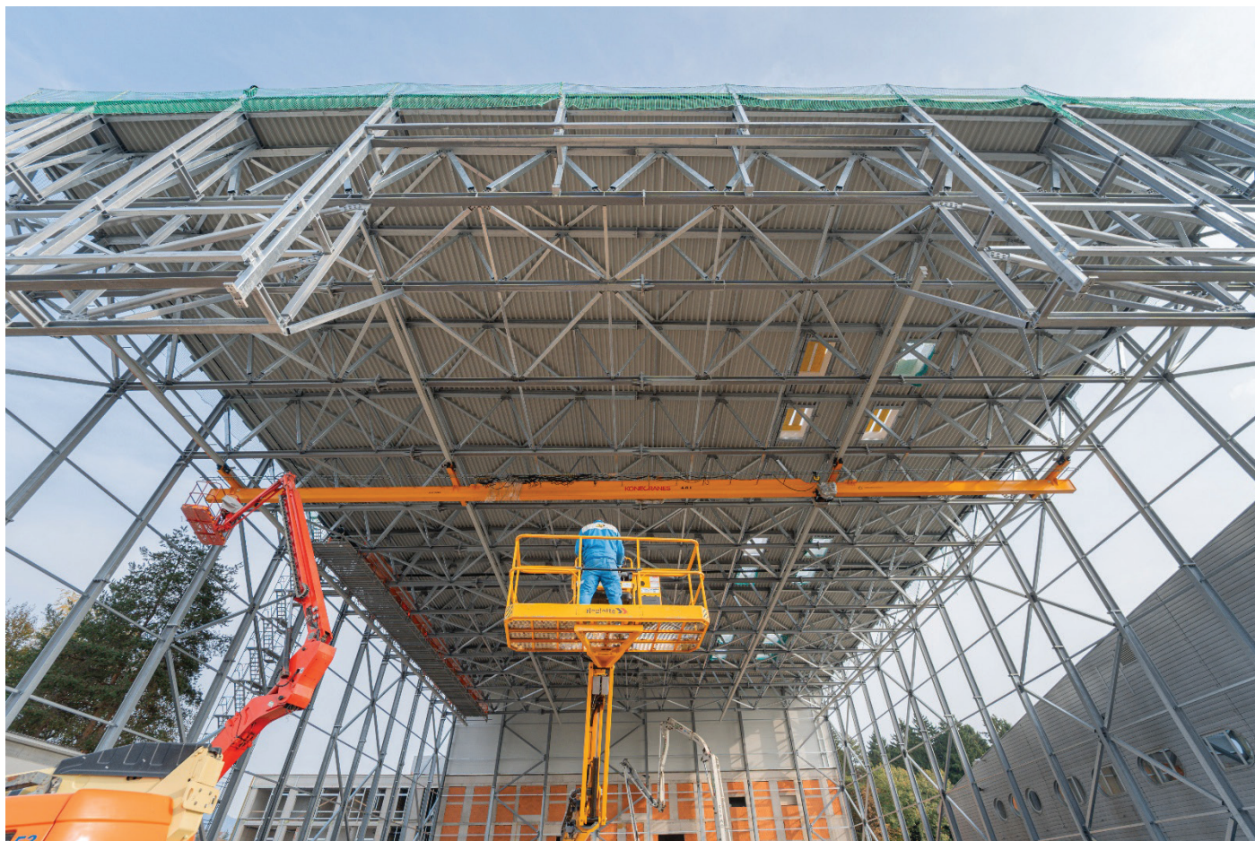
Slika 1. Hangar za vzdrževanje letal (foto: Nejc Vurnik).
