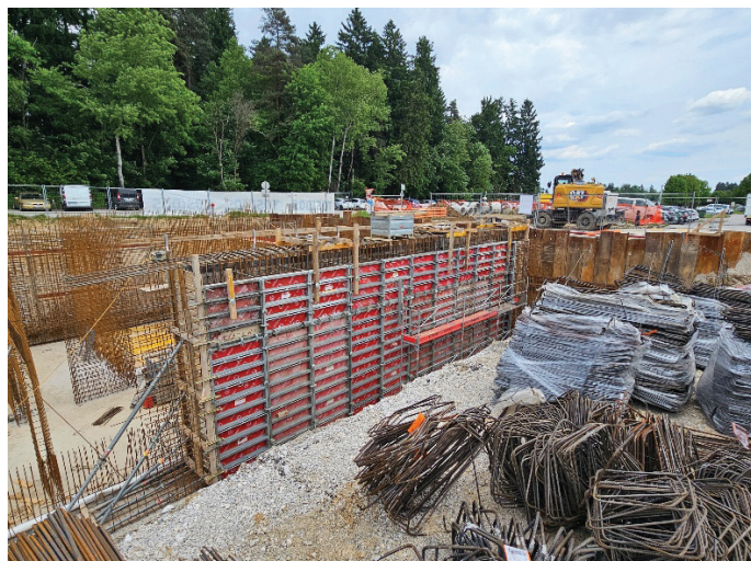
Slika 4. Prva kampada temelja, pripravljena na betonažo (foto: Petra Galo Volk).
