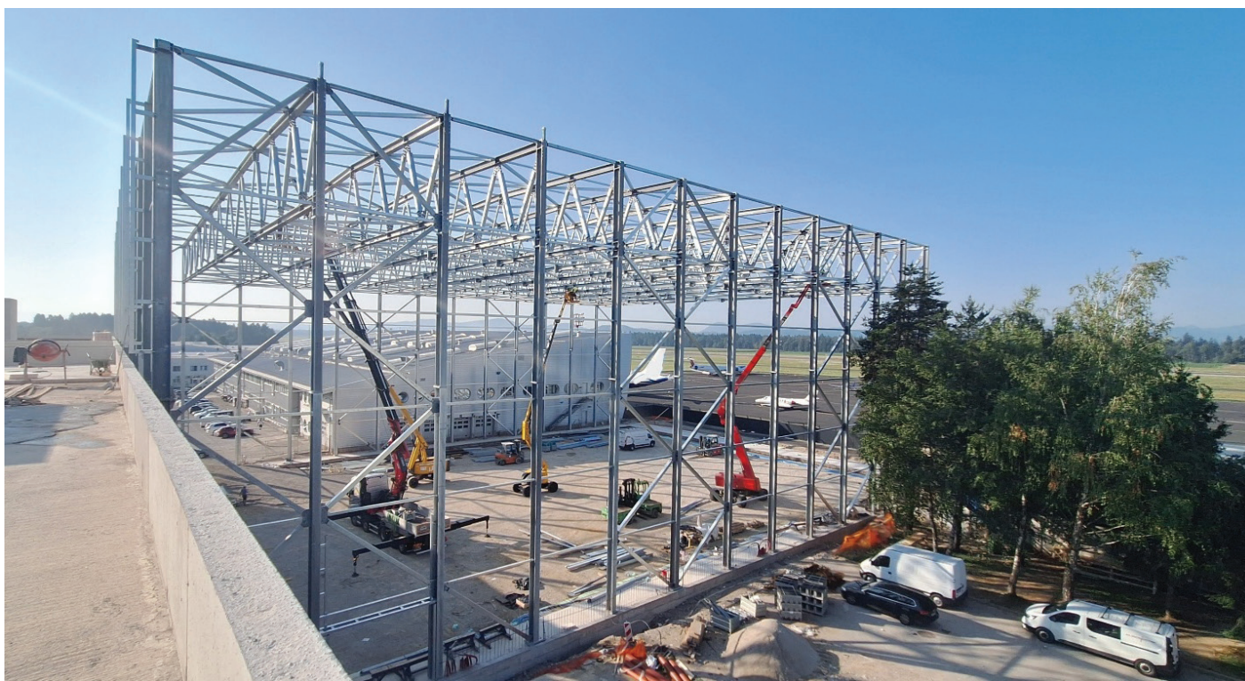
Slika 10. Konstrukcija hangarja (foto: Jernej Nučič).
