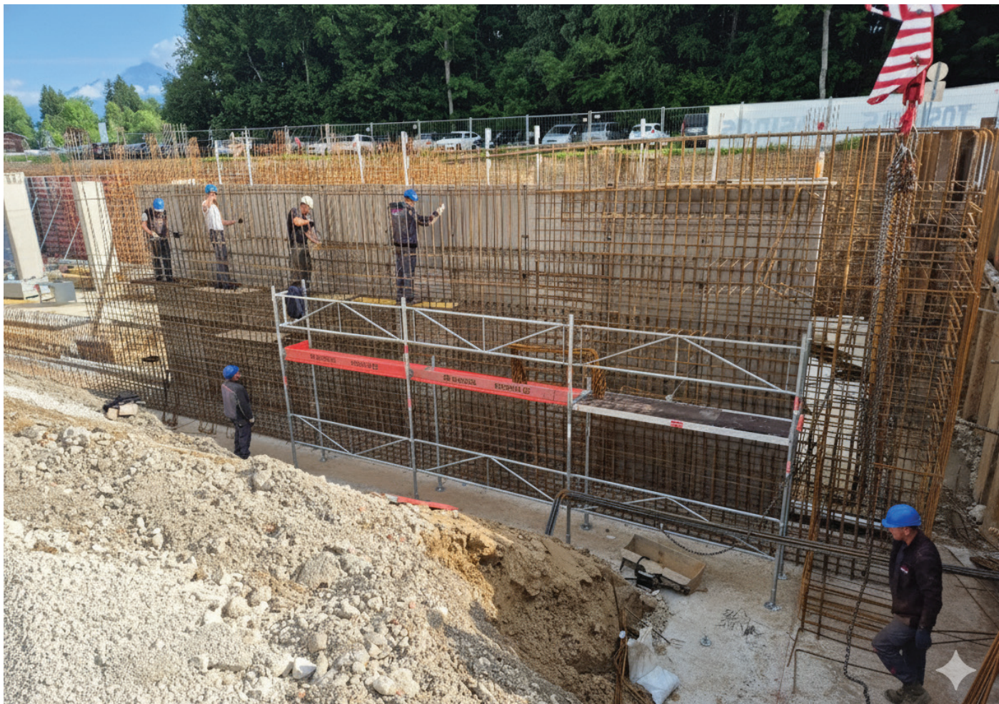
Slika 2. Vezanje armature v prvi kampadi pasovnega temelja (foto: Petra Galo Volk).
