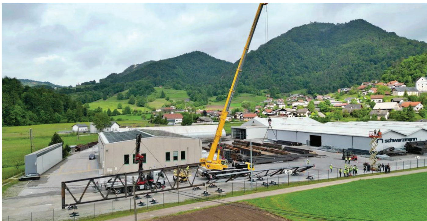
Slika 12. Testni dvig nosilca (foto: arhiv Schwarzmann).
