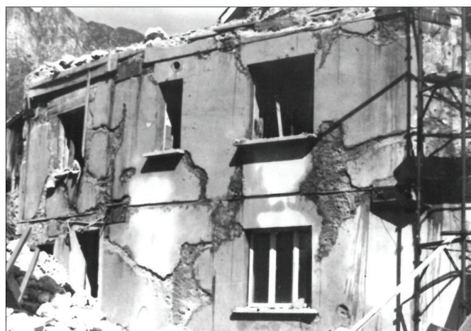
Slika 6. Hiša v Bardu (Lusevera), katere povezano in utrjeno zidovje je septembrska potresa prestalo brez poškodb. Levo: po septembrskem potresu (foto: E. Vugrinec), desno: hiša danes (foto: M. Žerajčič)
