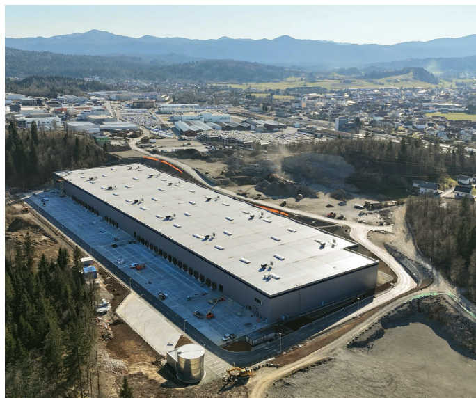
Slika 1. Logistični park Logatec proti koncu gradnje
