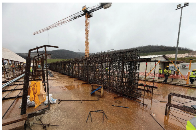
Slika 10. Armatura nosilca za most B0080
