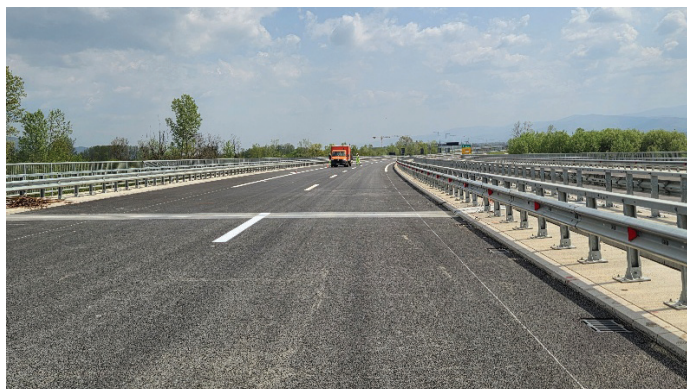
Slika 5. Zaključna dela na trasi
