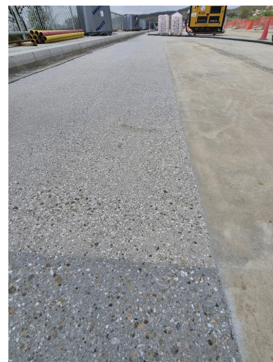
Slika 4. Priprava površine za izvedbo hidroizolacije
