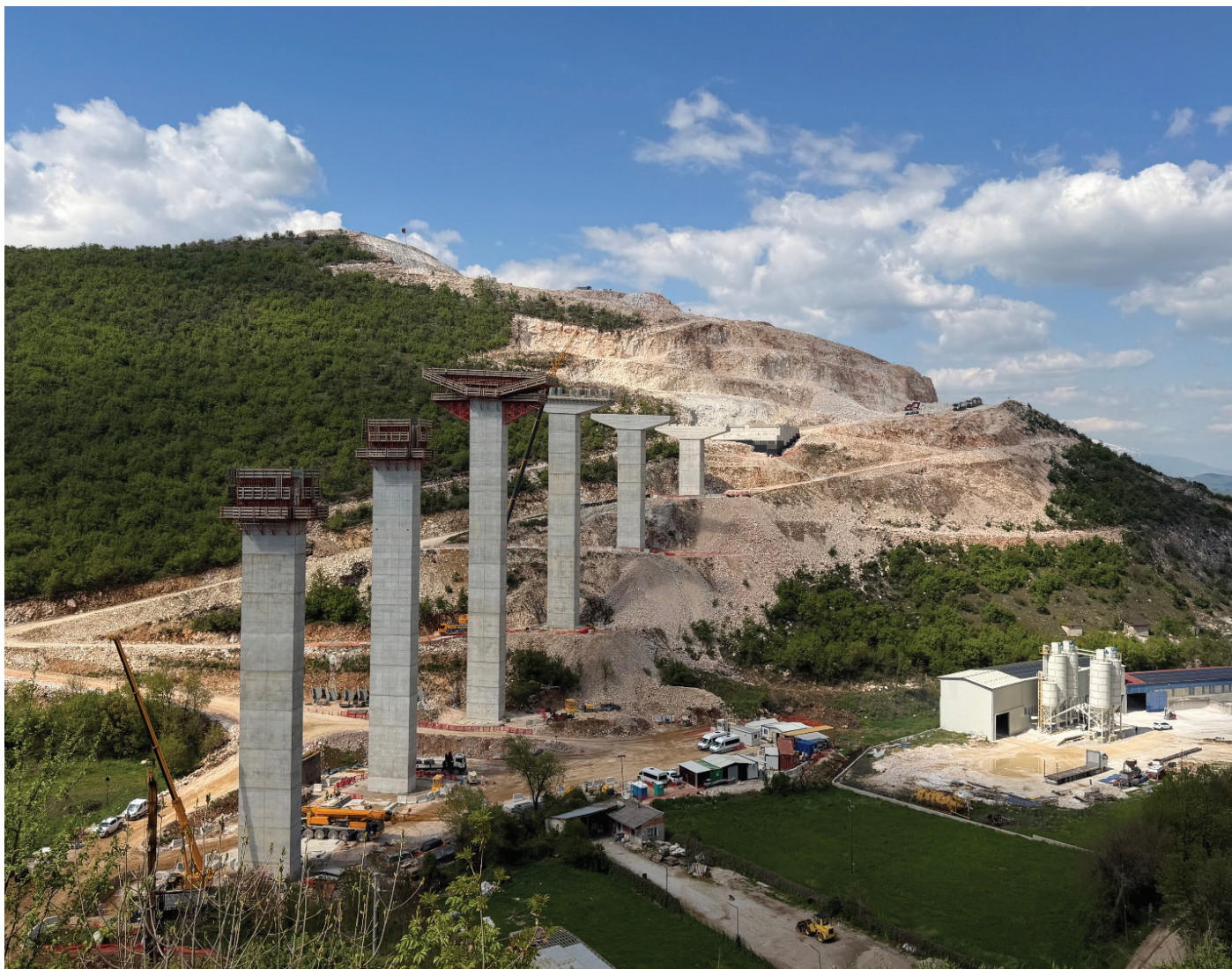
Slika 14. Gradnja mostu B00080. V ozadju gradnja izkopa v km 7+500. Predvidena količina izkopanega materiala, ki ga bodo uporabili za izvedbo nasipov avtocestnega telesa ter kot agregat za proizvodnjo betonov, je več kot 5 milijonov m 3
