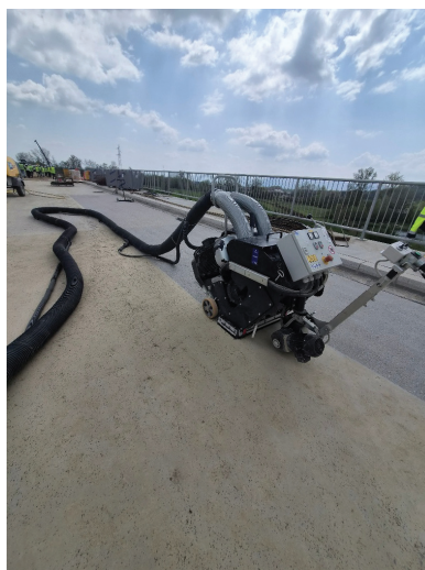
Slika 4. Priprava površine za izvedbo hidroizolacije
