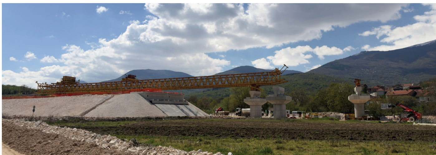
Slika 12. Montaža prefabriciranih prednapetih nosilcev na mostu Vardar B0051
