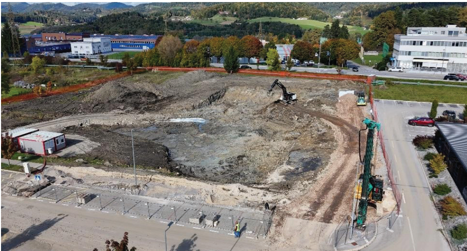
Slika 3. Izvedba zemeljskih del
