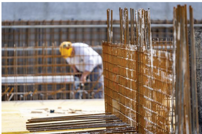
Slika 5. Postavljanje armature v kletni etaži objekta
