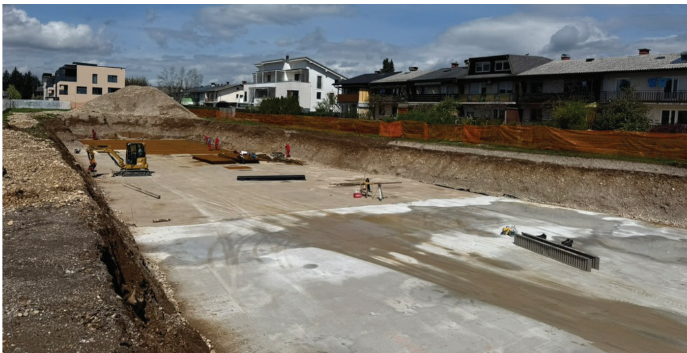
Slika 3. Priprava temeljne plošče
