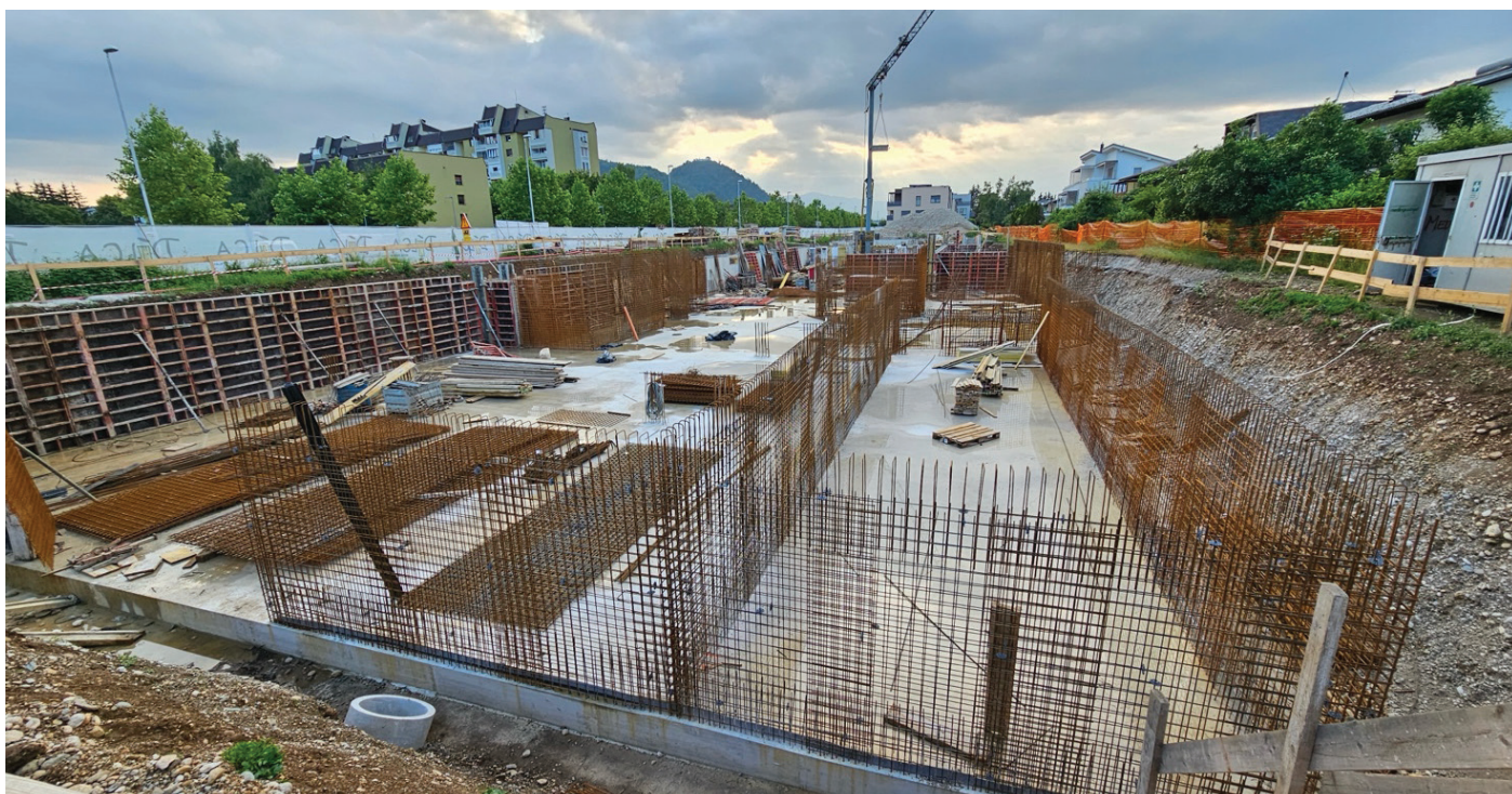
Slika 5. Izvedba kletne etaže
