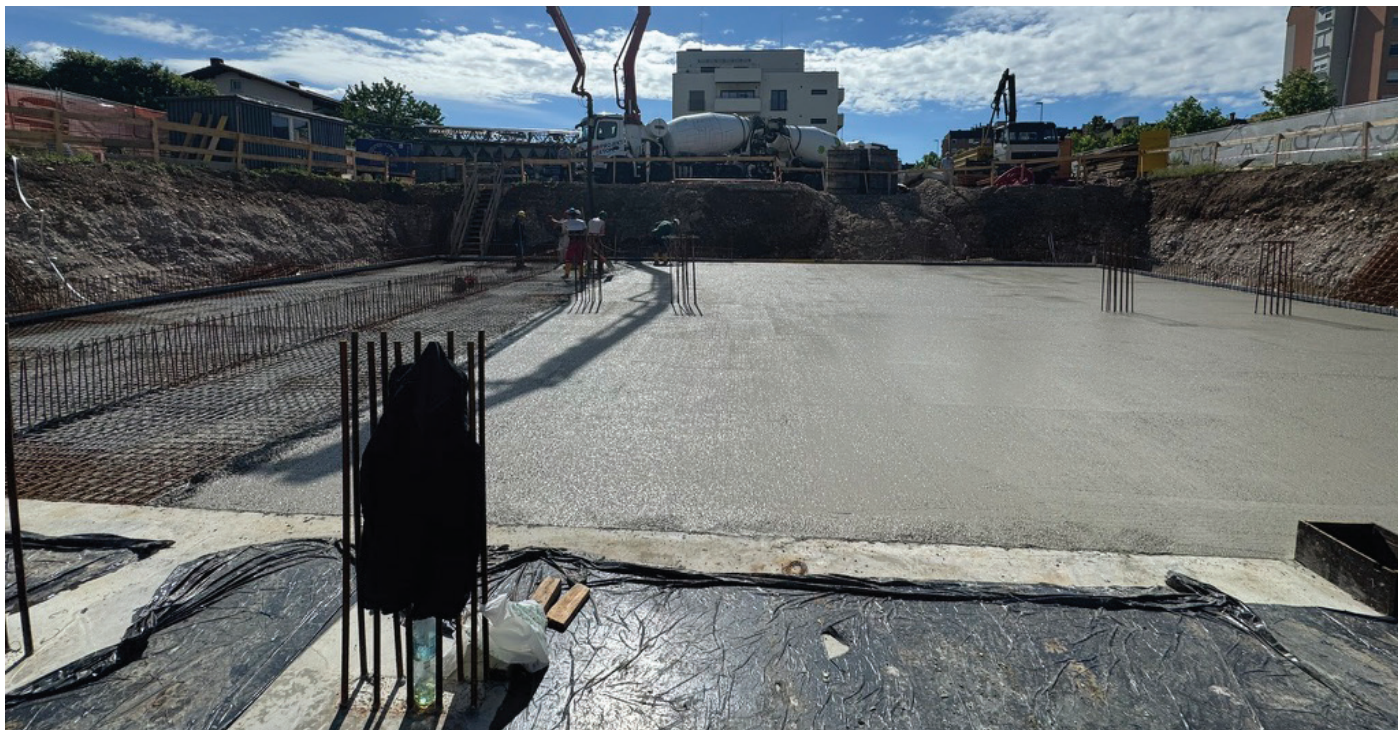
Slika 4. Betoniranje temeljne plošče
