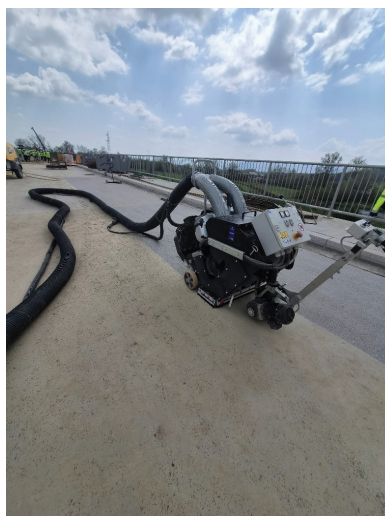
Slika 4. Priprava površine za izvedbo hidroizolacije
