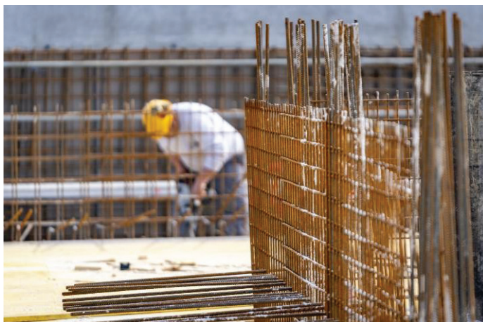
Slika 5. Postavljanje armature v kletni etaži objekta
