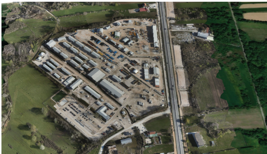
Slika 7. Nastanitveni gradbiščni kompleks za zaposlene v Severni Makedoniji. Tako v Srbiji kot v Severni Makedoniji sta vzpostavljena dva takšna kompleksa za zaposlene
