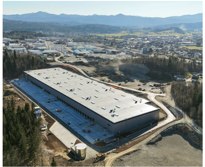
Slika 1. Logistični park Logatec proti koncu gradnje
