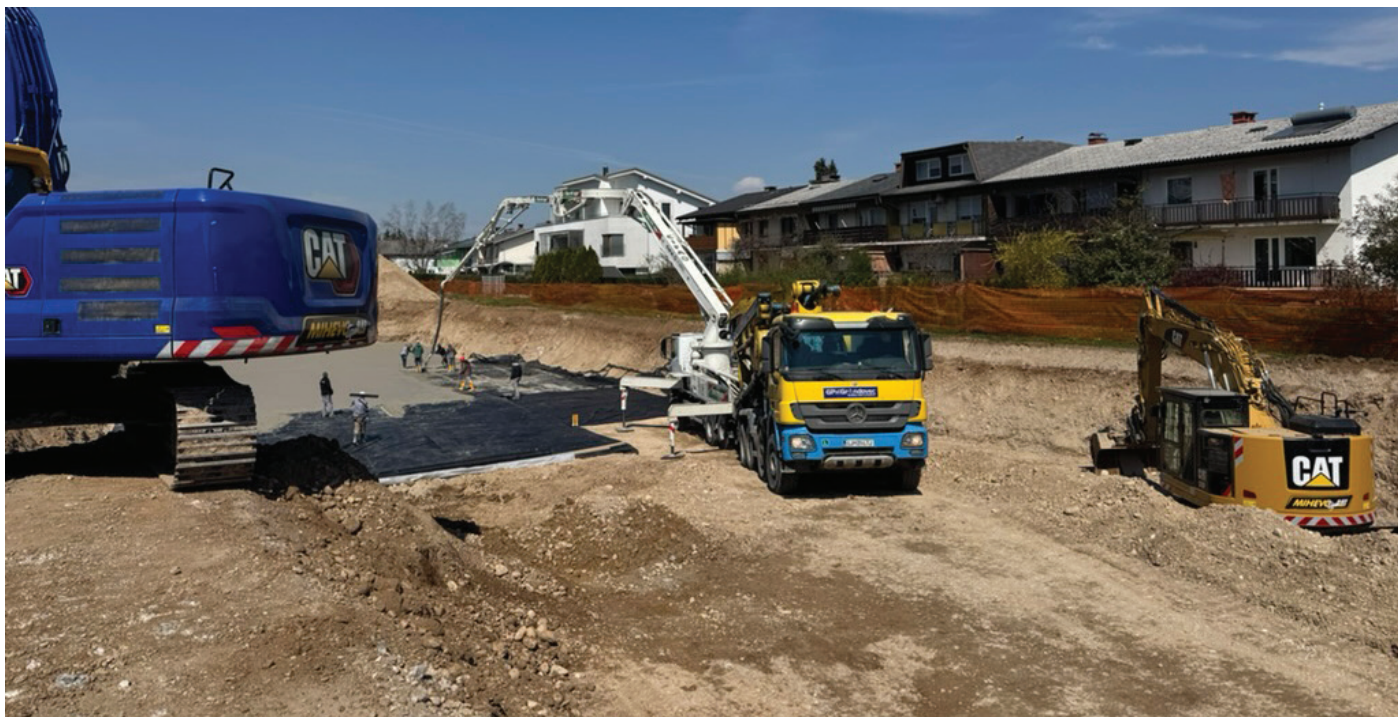
Slika 2. Začetna faza gradnje z izkopi, pripravo terena in podložnim betonom
