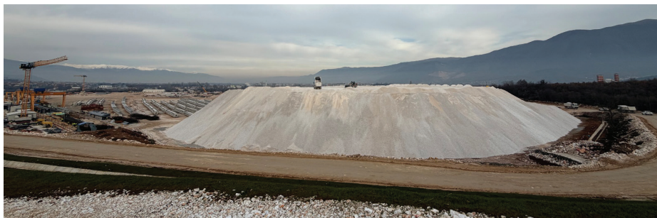
Slika 9. Deponija materiala, v ozadju prefabrikacijski obrat in deponija izvedenih prefabrikatov
