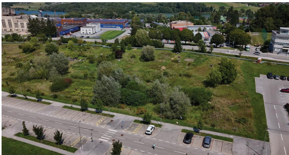
Slika 2. Območje pred začetkom gradnje v Velenju
