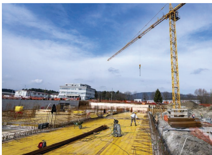
Slika 8. Začetek izvedbe prve etažne plošče
