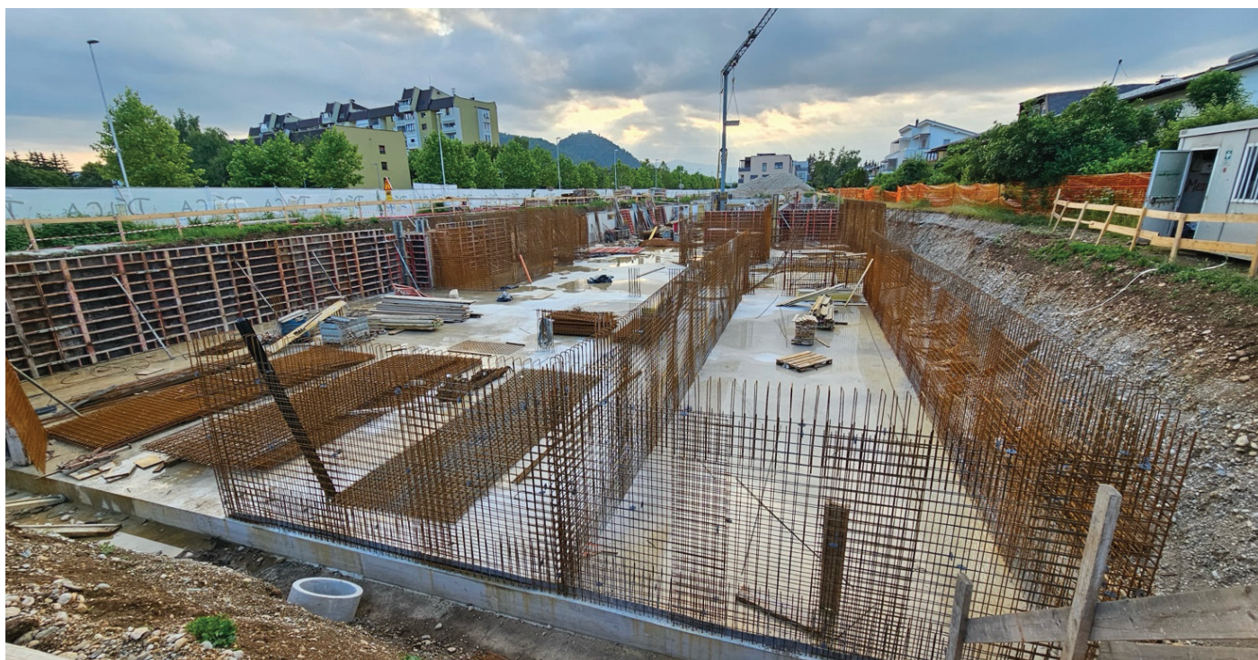
Slika 5. Izvedba kletne etaže
