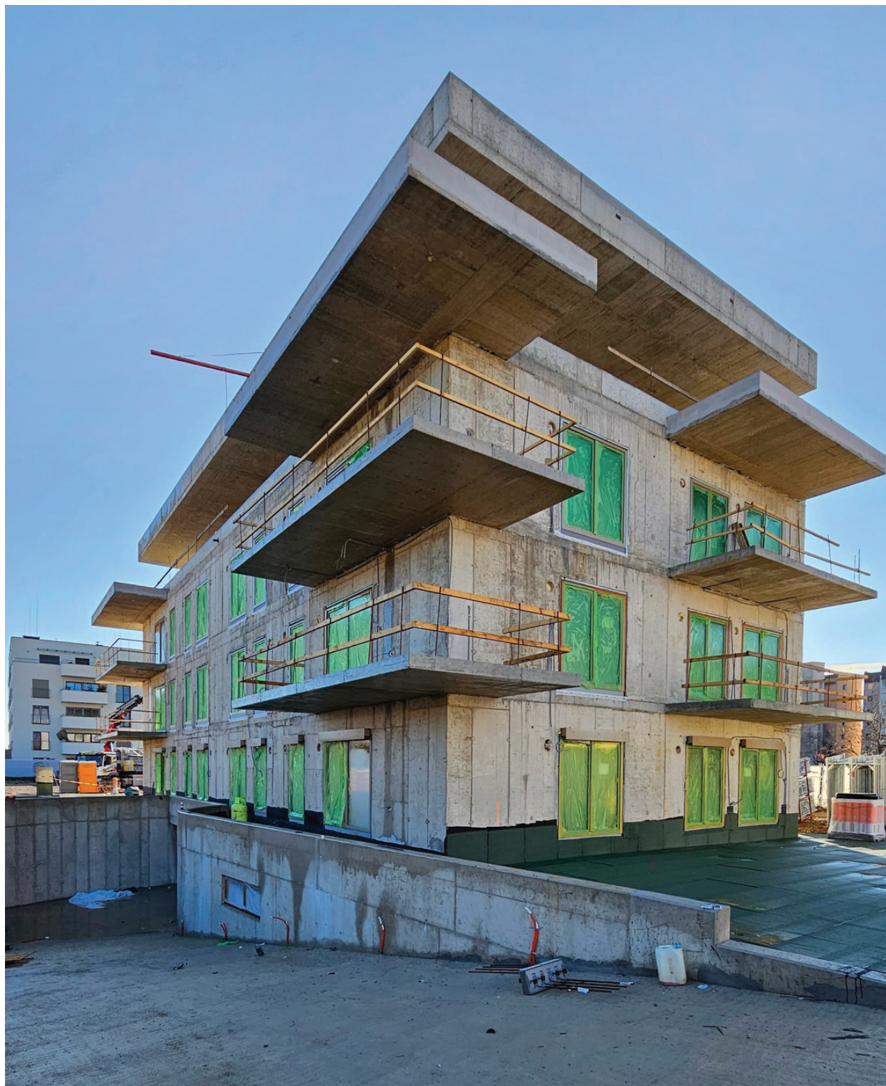
Slika 9. Dokončana AB konstrukcija z vgrajenim stavbnim pohištvom
