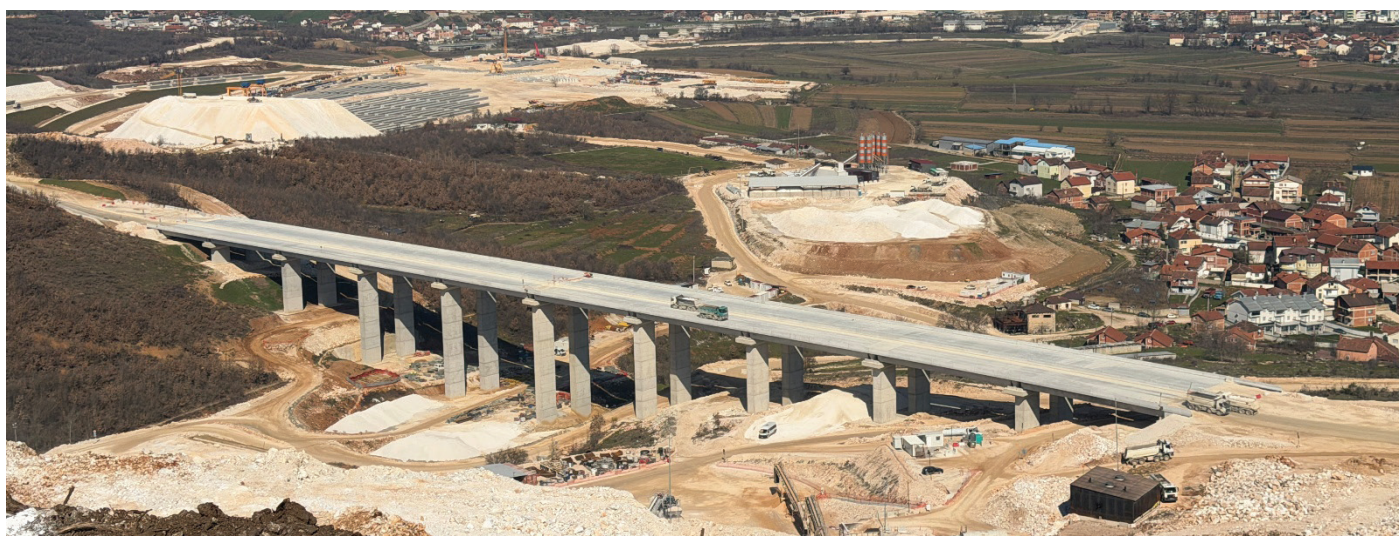
Slika 13. Gradnja mostu B00070
