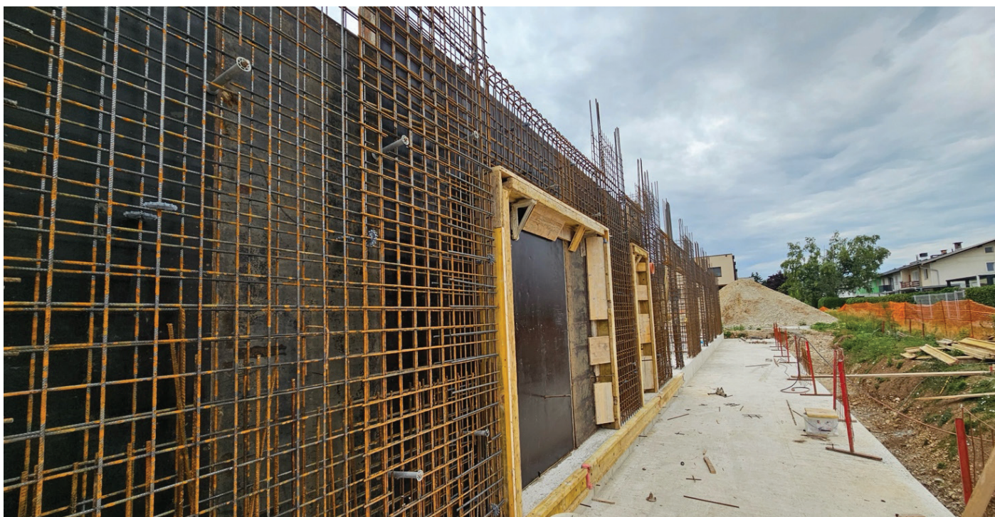
Slika 7. Izvedba sten pritličja
