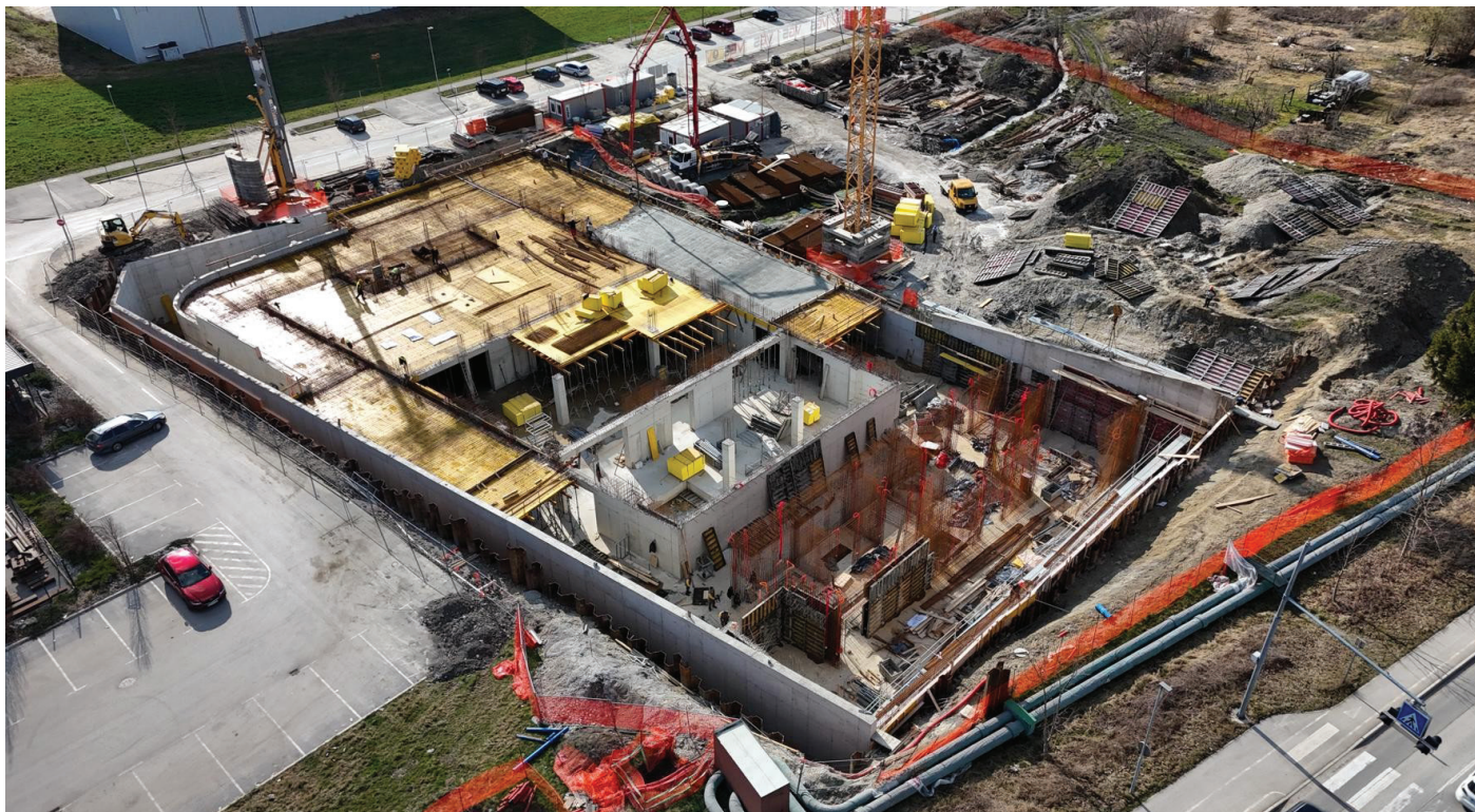
Slika 9. Trenutno stanje gradnje objekta TechHUB
