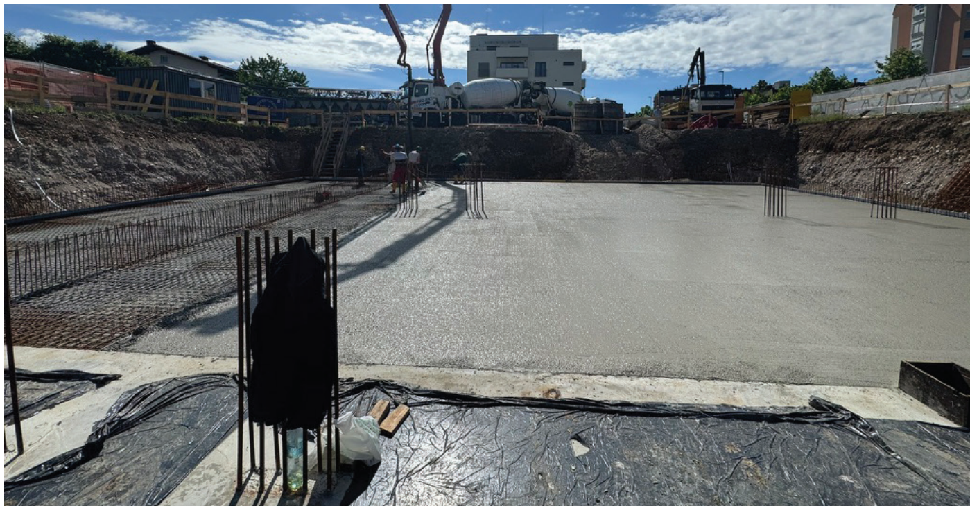
Slika 4. Betoniranje temeljne plošče
