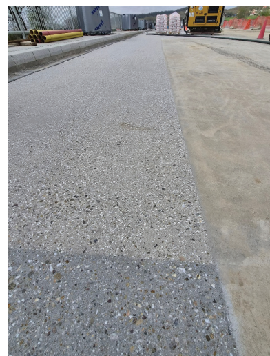
Slika 4. Priprava površine za izvedbo hidroizolacije
