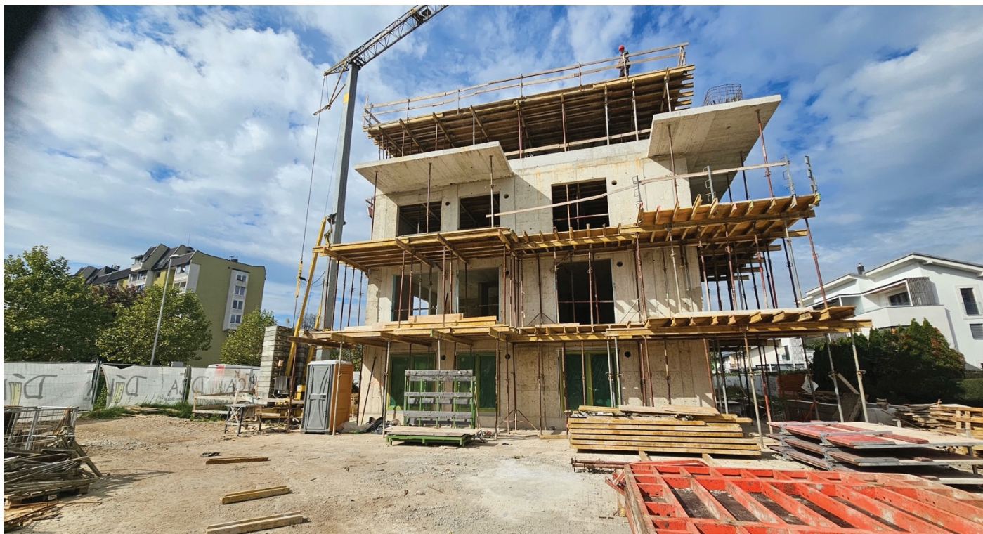
Slika 8. Pogled na lamelo B med gradnjo
