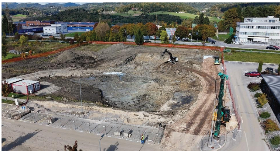
Slika 3. Izvedba zemeljskih del
